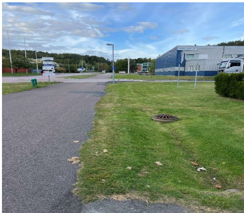
Figur 11. Exempel hur vägdagvatten och dagvatten förs i öppna svackdiken längs kvartermark. Notera trumman för en infart i bildens högra främre del samt den över mark något förhöjda kupolbrunnen som möjliggör svackdikets funktion och infiltrering.
