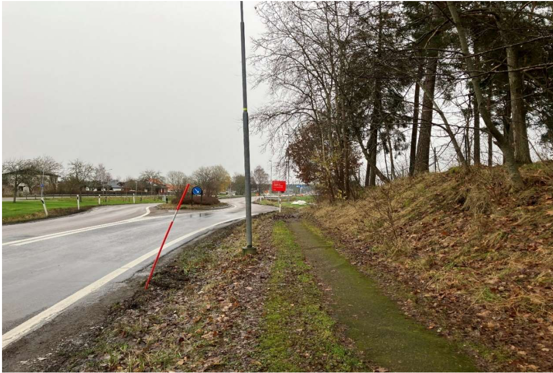
Foto 4: Läge för skyfallsdiket och överföringsledningen, här mot öster. Befintligt makadamdike syns längs Södergatan, till vänster i bild. I bildens högra del syns den högre höjden inom naturmarken.
