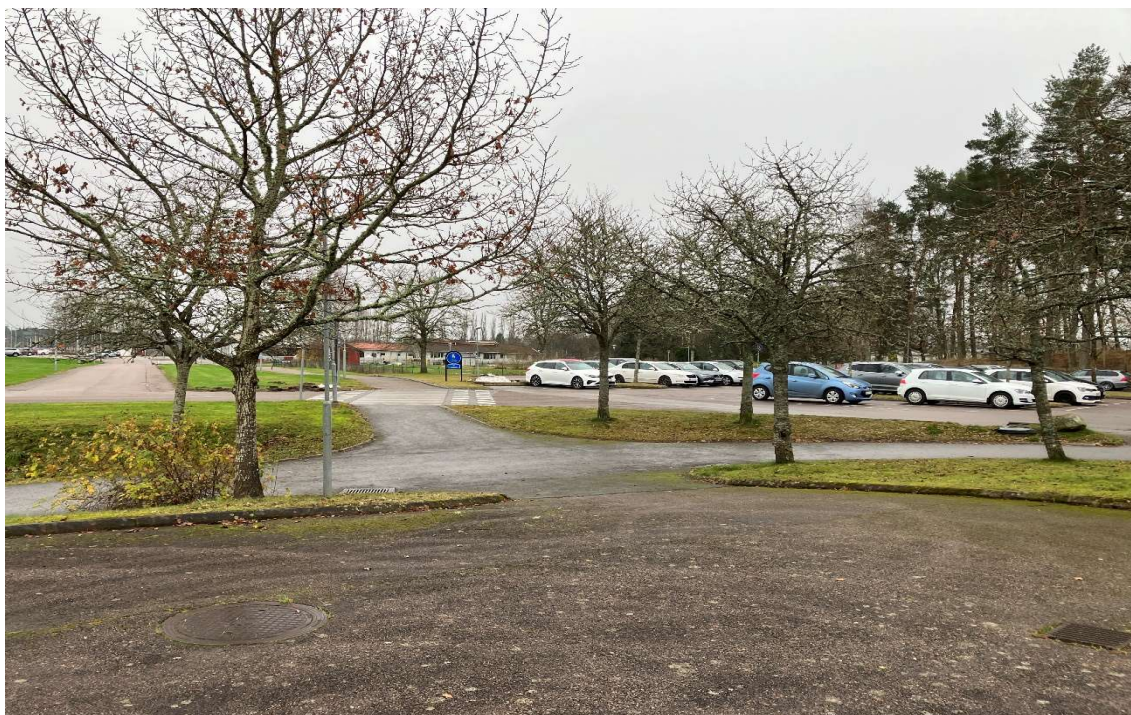
Foto 1: I bildens framkant syns en del av nuvarande asfaltytor inom detaljplanen som idag är anslutet till kommunens dagvattennät. I området öster om detaljplanen anläggs en skolskjutshållplats på befintlig parkering, grönytor etc. Ny dagvattenavledning från detaljplanen föreslås att korsa under den planerade entrévägen för skolskjutstrafiken.
