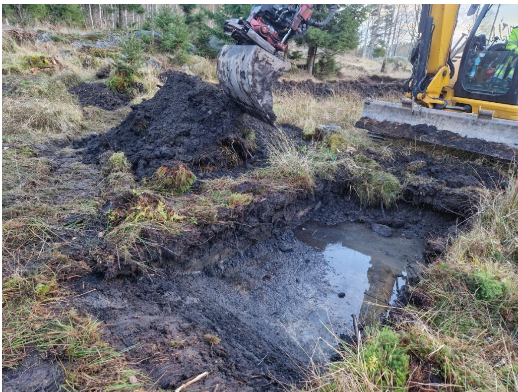
Fig. 1. Vattenfyllt schakt i undersökningsområdets mitt. Foto från N.
