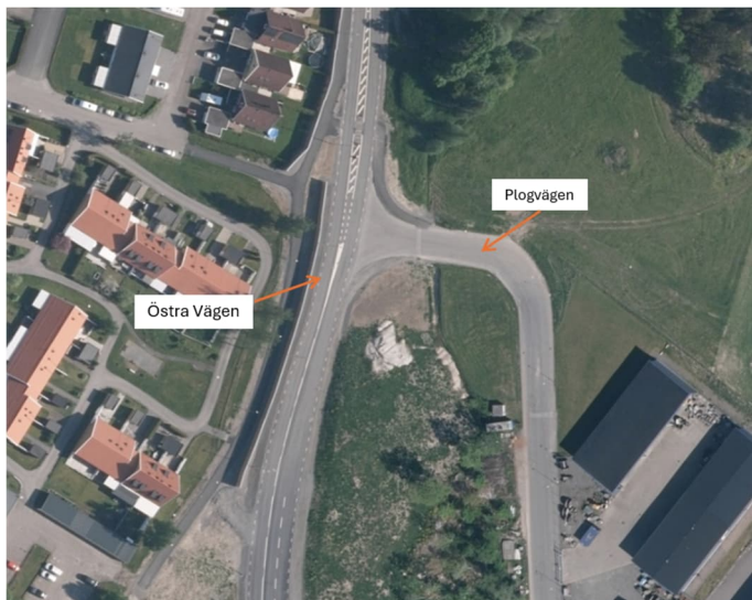
Figur 2: Trevägskorsningen där det befintliga verksamhetsområdet ansluter till Östra Vägen via Plogvägen. Bildkälla: Lantmäteriet, bearbetad av Norconsult
