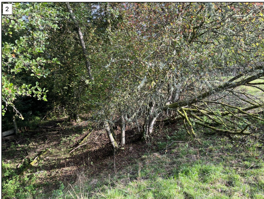
Figur 6-2 – Skredslänt med växtlighet vid släntrön.
