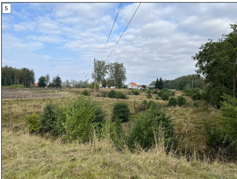
Figur 6-5 – Släntkrön närmst i bild följt av Mjölån med dess intilliggande skogsriddå. Kraftledning genom området.
