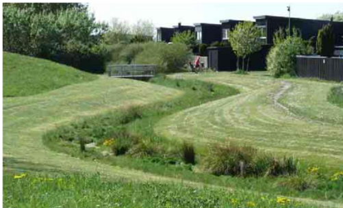
Figur 4 Exempel på större biodike i Fjärilsparken, Malmö (Blue Green Fingerprints).
