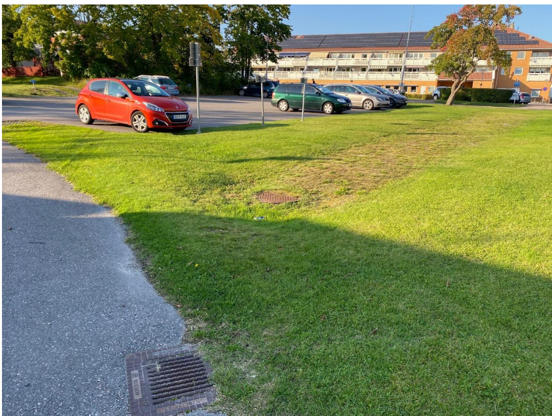
Figur 5 Visar befintlig dagvattenbrunn och kringliggande grönytor i lågpunkt i den sydöstra delen av området 2020-09-15 (Ensucon AB).
